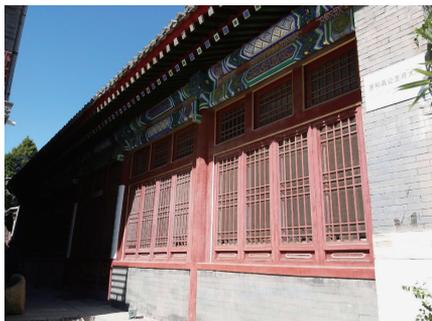
图 11 经过改建门窗推至廊柱外边的原公主府正殿今貌
